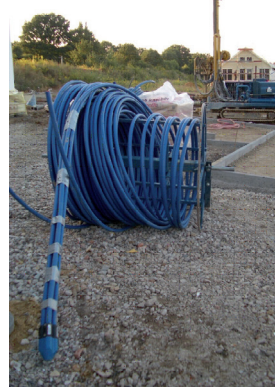
Ryc. 4. Przykłady geometrii stosowanych gruntowych pionowych wymienników ciepła oraz fotografia rury BHE „podwójne – U” o długości 100 m gotowej do montażu
